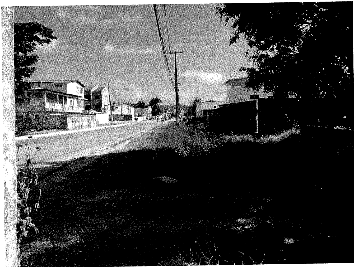
Foto 03: Situação atual do Trecho E13+0,00 à E20+0,00
