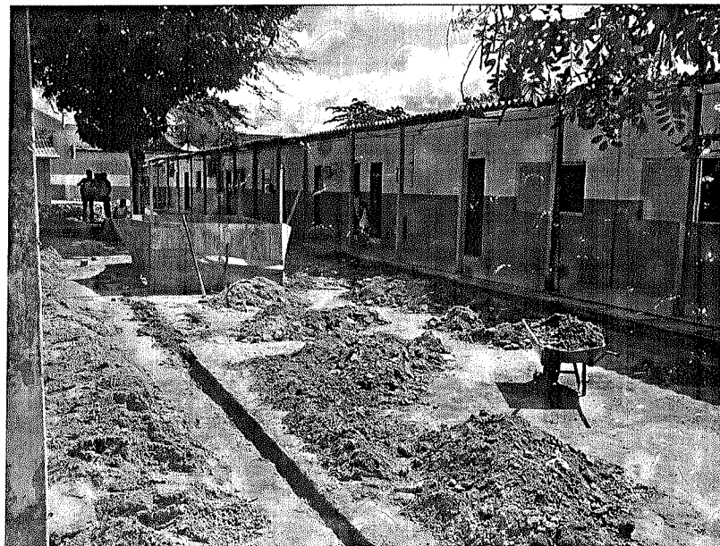
REGULARIZAÇÃO E TRANSPORTE COM CARRO DE MÃO
