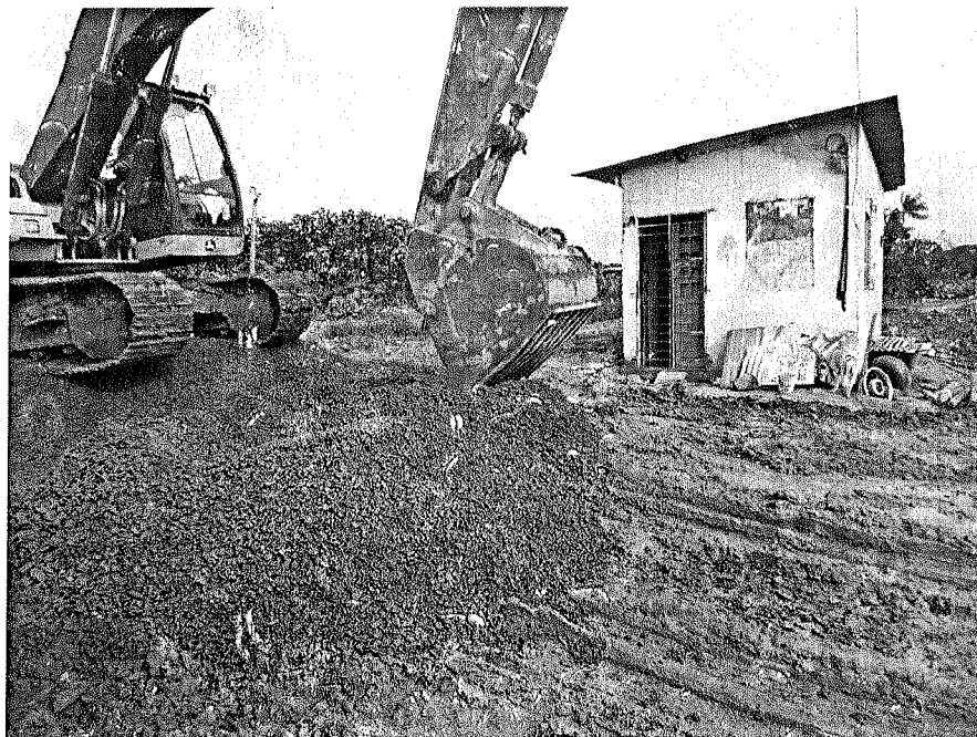
Foto 40 -- Execução da camada de brita corrida
