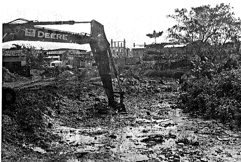
Foto 43 – Escavação em solo mole
