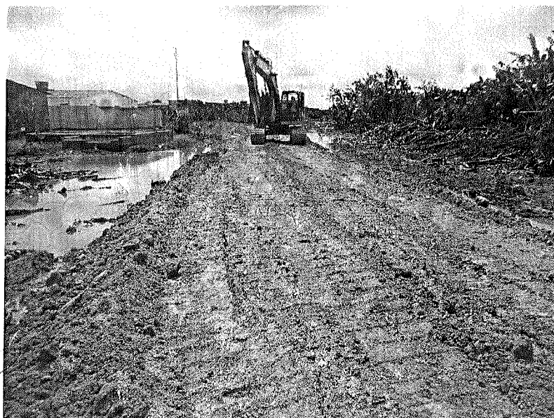
Foto 10 – Aterro do caminho de serviço
