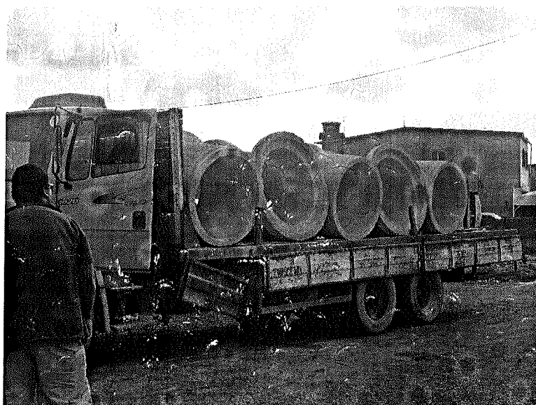
Foto 34 – Fornecimento dos Tubos de concreto armado DN 1,0M
