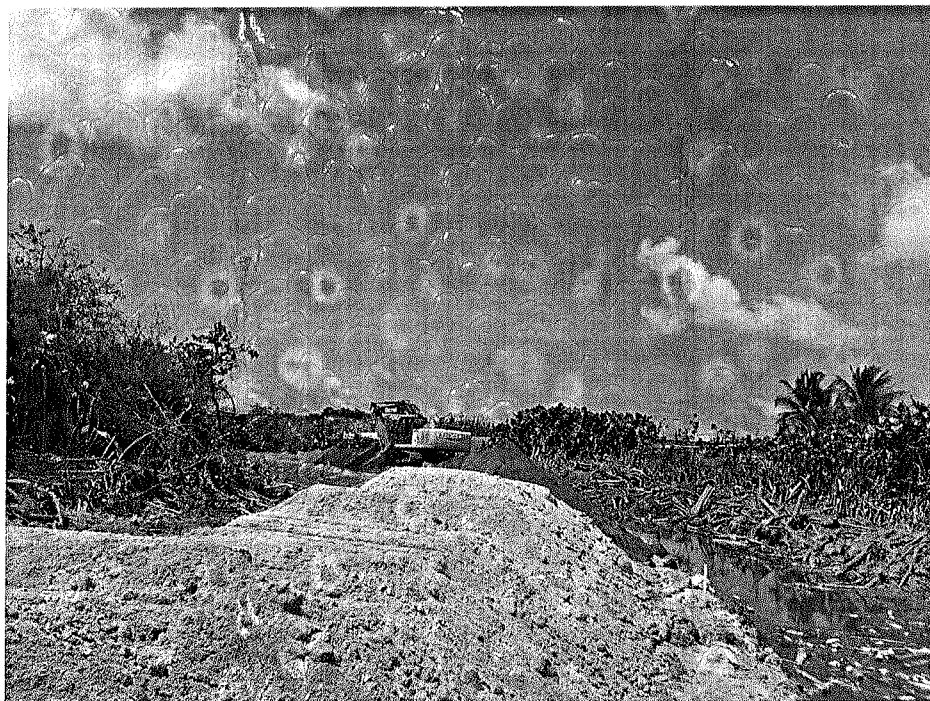
Foto 17 – Mostra caminho de serviço 1ª camada aterro com areia, 2ª camada aterro com barro.
