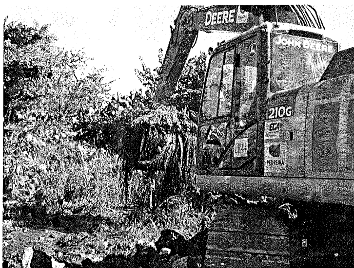
Foto 04 – Limpeza de ponta para posterior implantação do caminho de serviço
