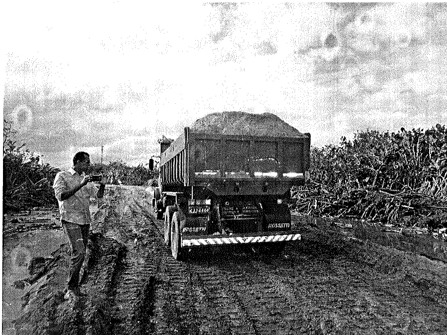
Foto 32 – Barro para caminho de serviço
