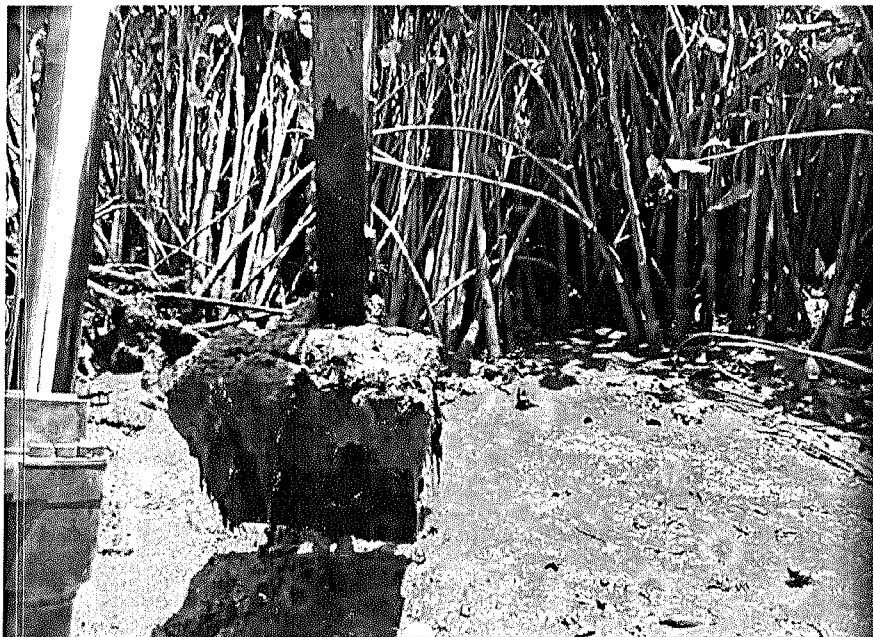
Foto 07 - Escavação para a base do caminho de serviço
