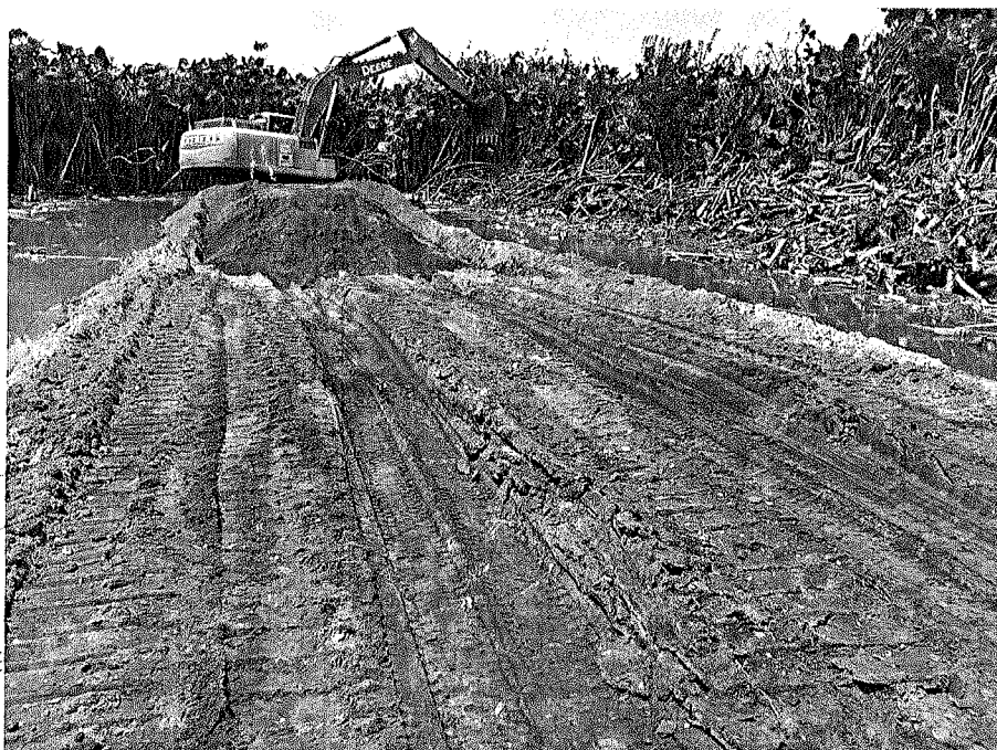
Foto 26 – Execução do aterro com areia. Observar que o caminho de serviço está completamente tomado por água e lama. Vai e colocando areia até atingir uma resistência mínima para receber uma camada de barro que possibilite o tráfego de máquinas e caminhões
