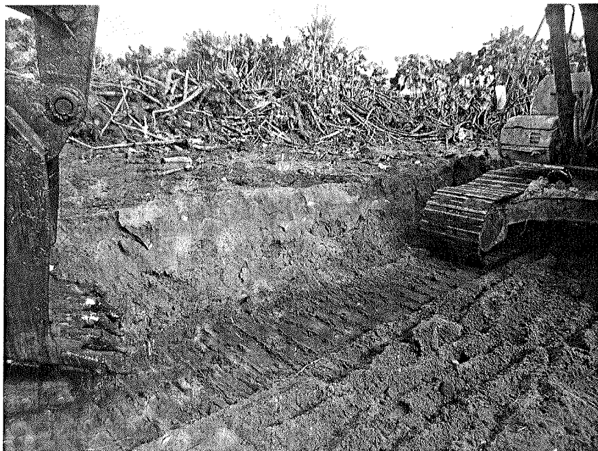
Foto 27 a lama misturada com a areia vai sendo expurgada, depois se completa a vala com areia e depois a camada de barro. Atentar que antes era água e lama conforme se ver nas fotos 18, 19 e 26
