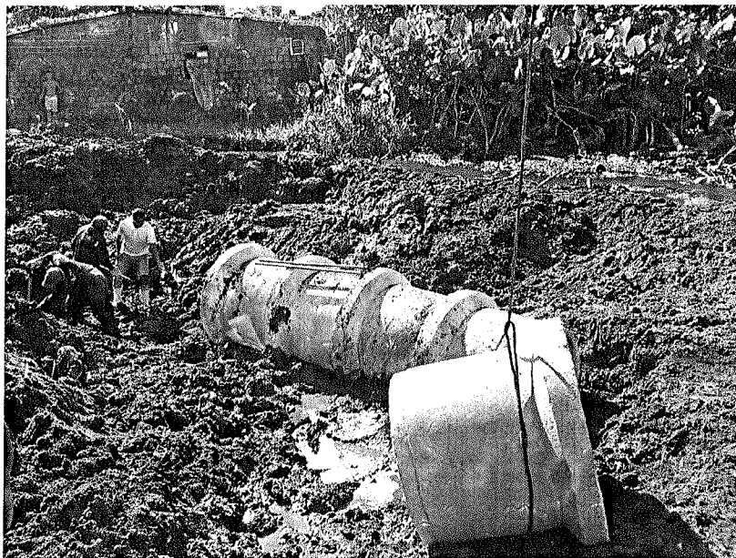
Foto 36 - Assentamento de tubos de concreto DN 1,0M
