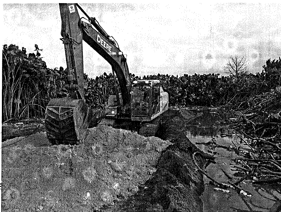
Foto 28 – Caminho de serviço em execução. Ver que primeiro se retirou a lama, executou o aterro com areia para só depois entrar com o barro.
