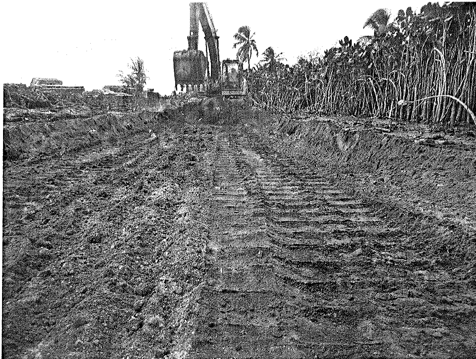
Foto 21 – Ver aterro com areia do caminho de serviço sendo executado dentro do charco. Importante observar também as condições da ponta deste aterro na foto 04, 06, 07 e 08.
