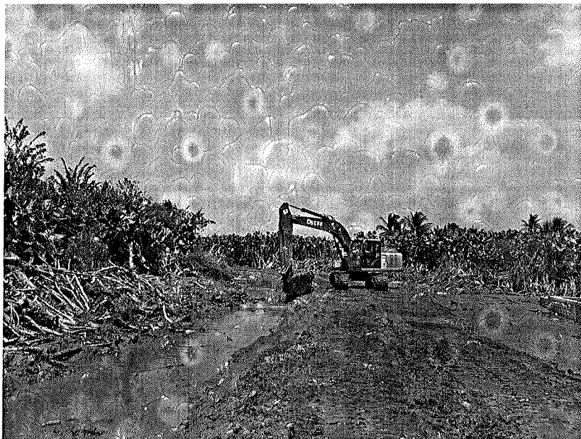
Foto 49 A – Escavação em solo mole.
