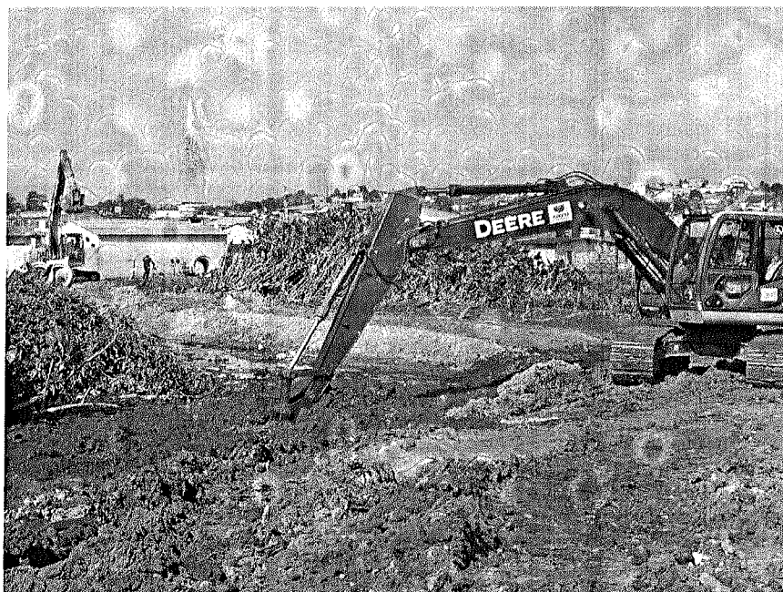
Foto 49 B – Escavação em solo mole no leito do canal
