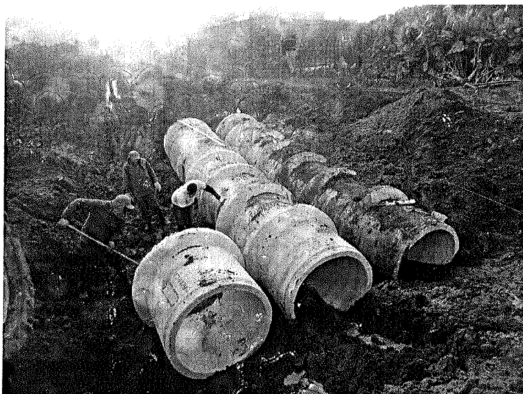
Foto 37 – Bueiro triplo em tubos de DN 1,0M
