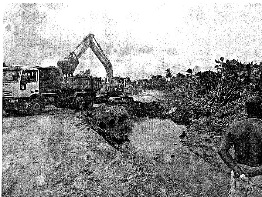
Foto 49 – Escavação e carga de solo mol, transporte para o local de secagem
