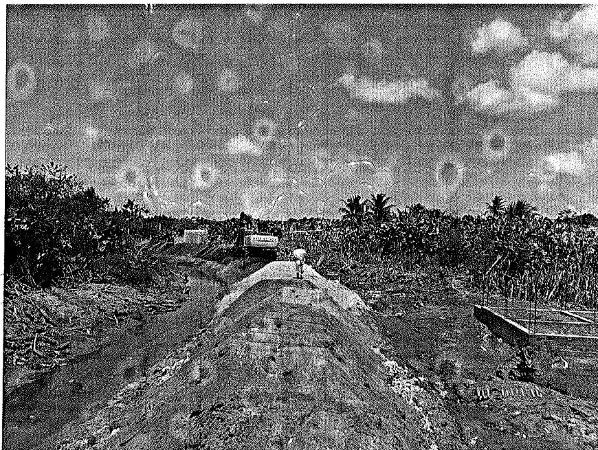
Foto 24 – Durante a execução, se faz o estoque de volumes de areia, para ir aterrando a ponta do caminho de serviço a abrindo caminho dentro do charco.
