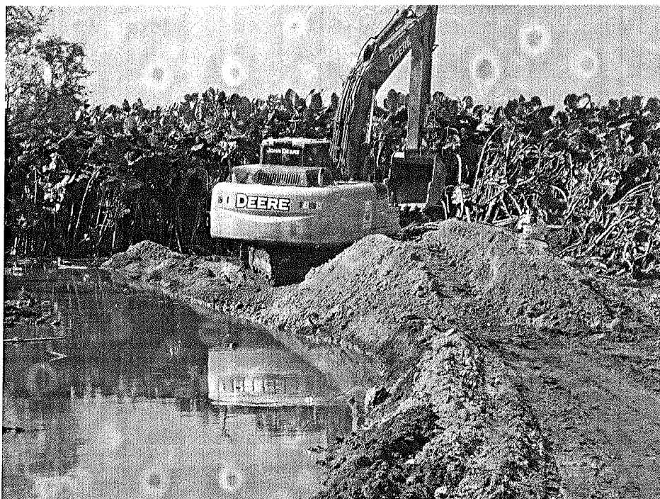
Foto 14 – Mostra a execução da camada de barro após a camada drenante de areia ter estabilizado a base
