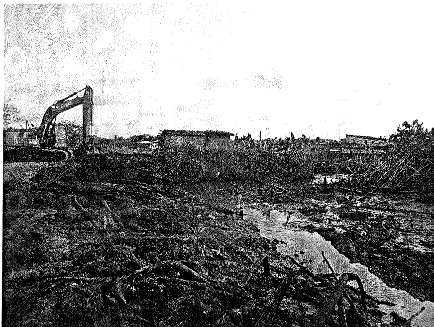
Foto 47 – Escavação em solo mole
