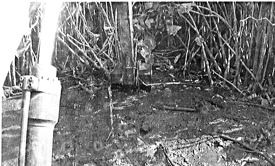
Foto 44 – Escavação em solo mole
