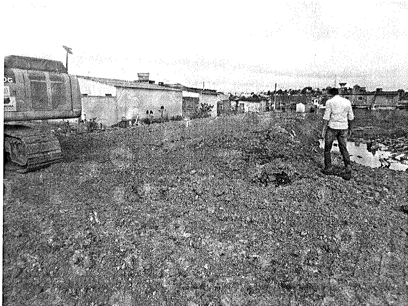
Foto 11 – Aterro Caminho de Serviço
