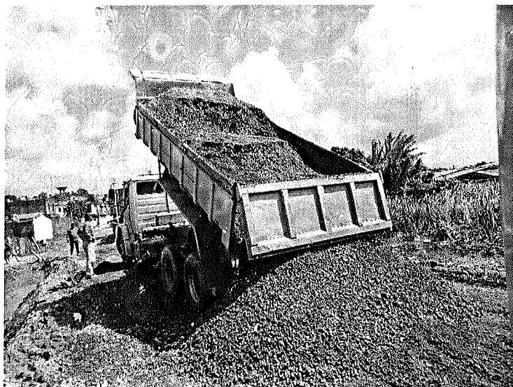
Foto 38 – Brita para camada de reforço em dias de chuva
