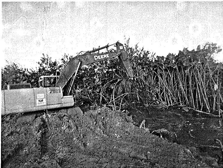
Foto 05 -- Escavação para base do caminho de serviço
