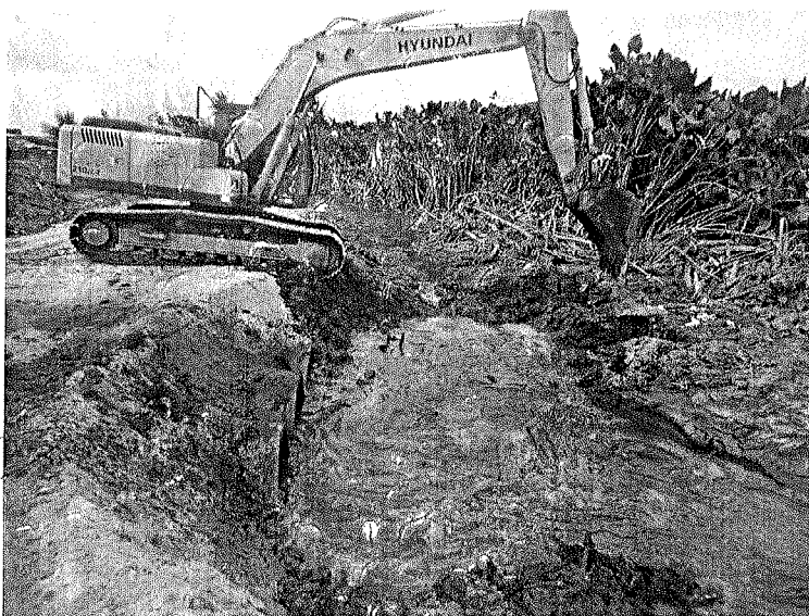
Foto 41 – Escavação em material tipo solo mole
