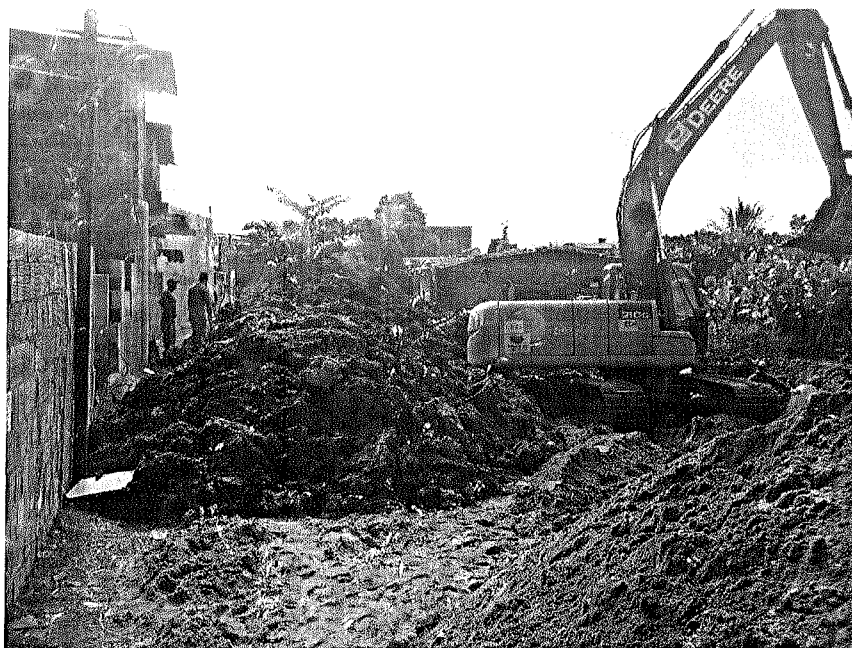
Foto 48 – Escavação em solo mole
