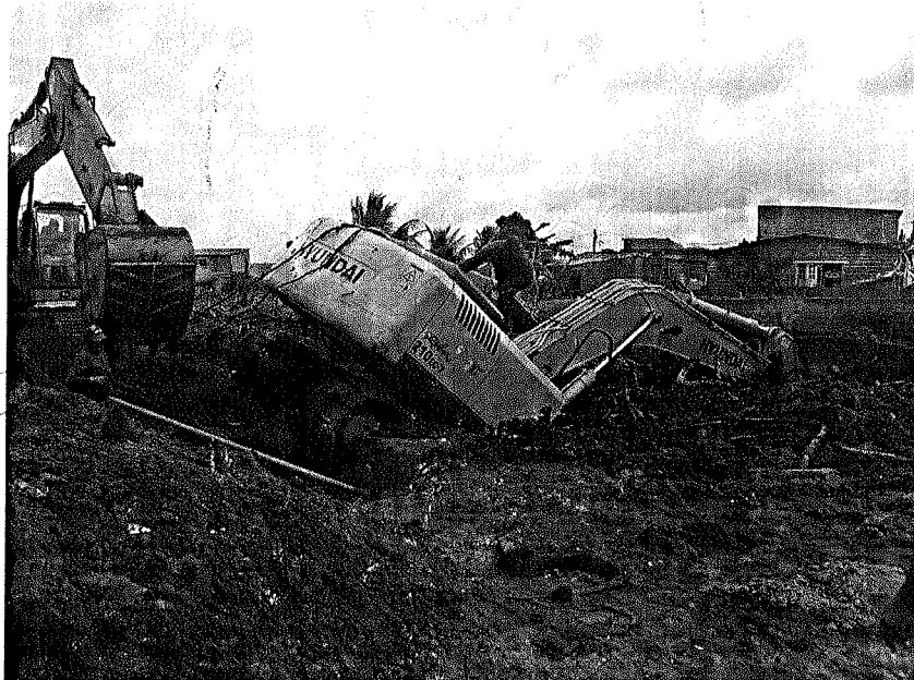
Foto 22 – Ver que o solo da foto, já é uma mistura da lama com areia colocada, mais ainda não atingiu a resistência de suporte de carga suficiente. Sendo imprescindível a drenagem total para só depois entrar com a camada de barro. (Escavadeira Hidráulica atolada)
