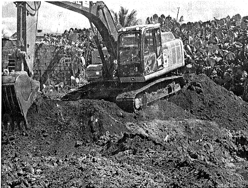
Foto 25 – Execução do aterro com areia
