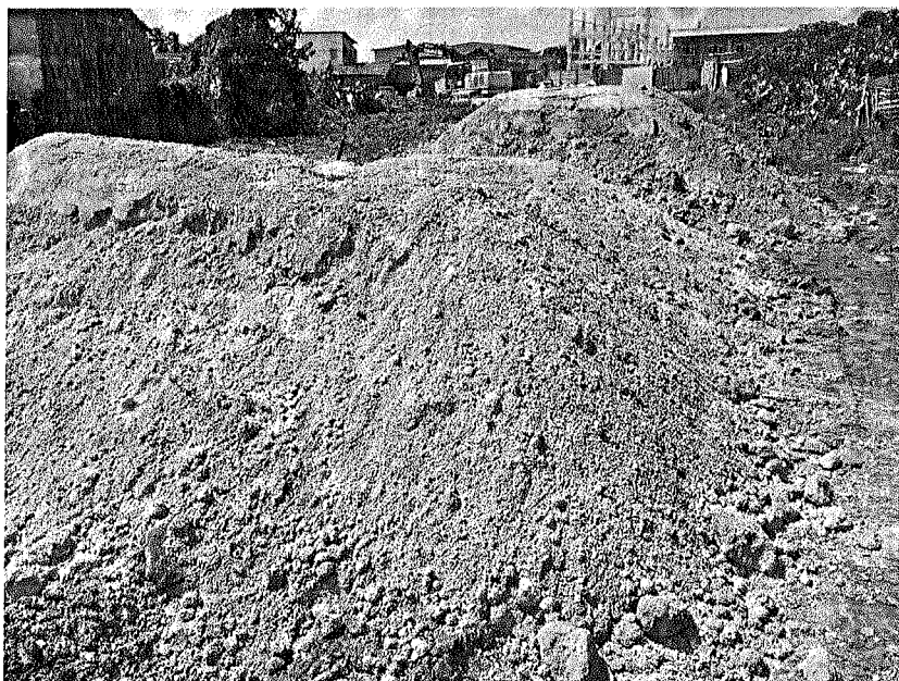
Foto 13 – Material para aterro de caminho de serviço
