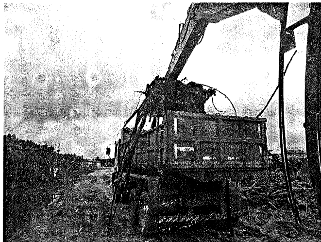
Foto 46 – Carga e transporte do material escavado para o local de secagem
