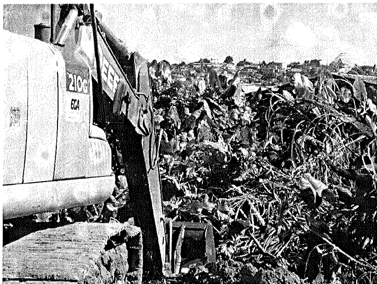
Foto 03 – Limpeza do Terreno
