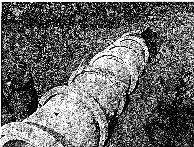
Foto 36 - Assentamento de tubos de concreto DN 1,0M
