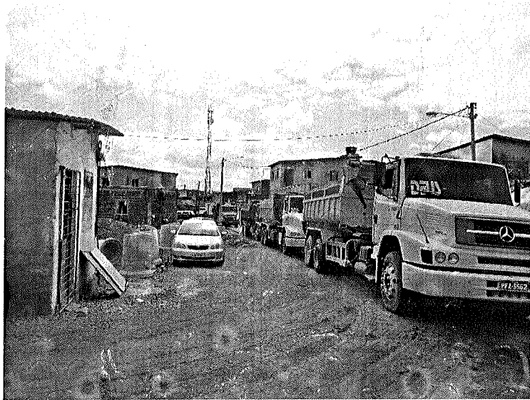
Foto 31 - Fila de caminhão basculante na entrada da obra para aferição do volume e apontamento das fichas de areia e barro.
