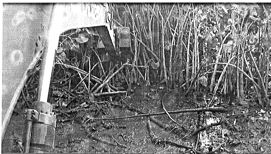
Foto 08 – Escavação na ponta do aterro para caminho de serviço
