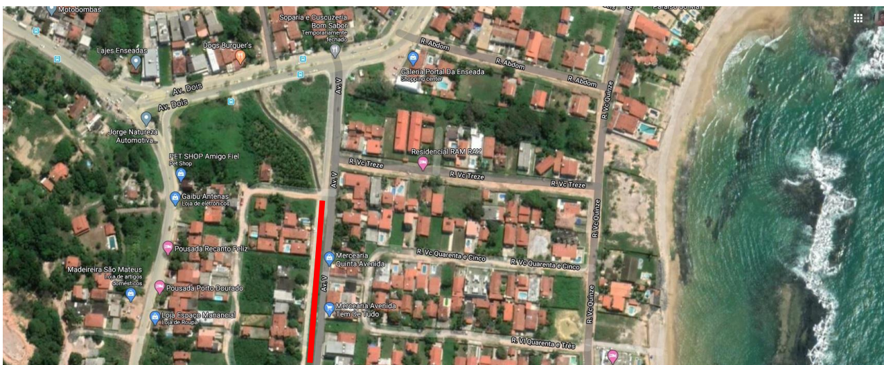
Foto 2: Trecho da E56+0,00 à E66,0,00, lado esquerdo da via
