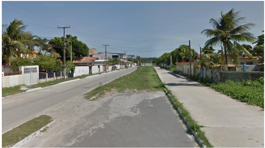
Foto 04: Situação atual do Trecho E56+0,00 à E66+0,00
