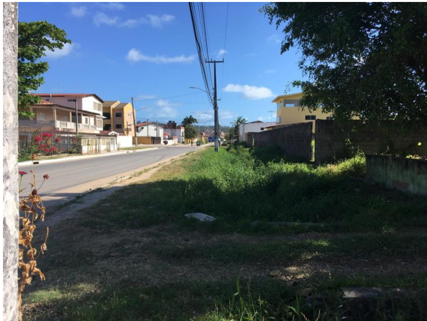
Foto 03: Situação atual do Trecho E13+0,00 à E20+0,00
