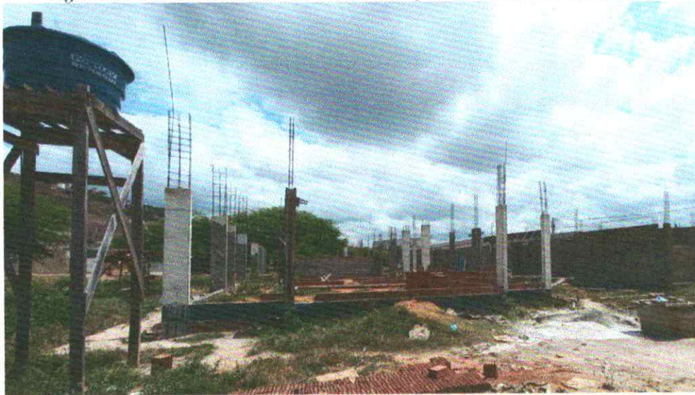
Figura 20. ESTADO ATUAL DA CONSTRUÇÃO DA CRECHE GAVIÃO.
