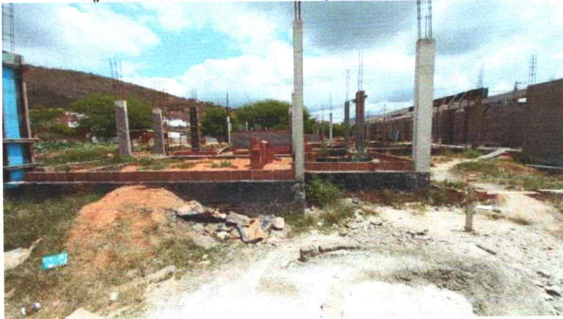
Figura 6. ESTADO ATUAL DA CONSTRUÇÃO DA CRECHE GAVIÃO.
