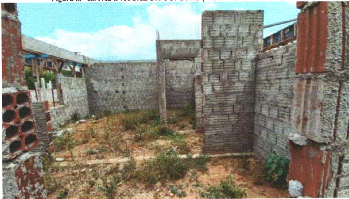
Figura 8. ESTADO ATUAL DA CONSTRUÇÃO DA CRECHE GAVIÃO.
