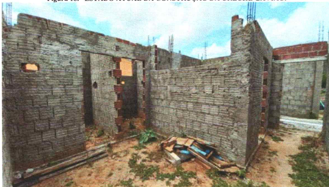
Figura 18. ESTADO ATUAL DA CONSTRUÇÃO DA CRECHE GAVIÃO.
