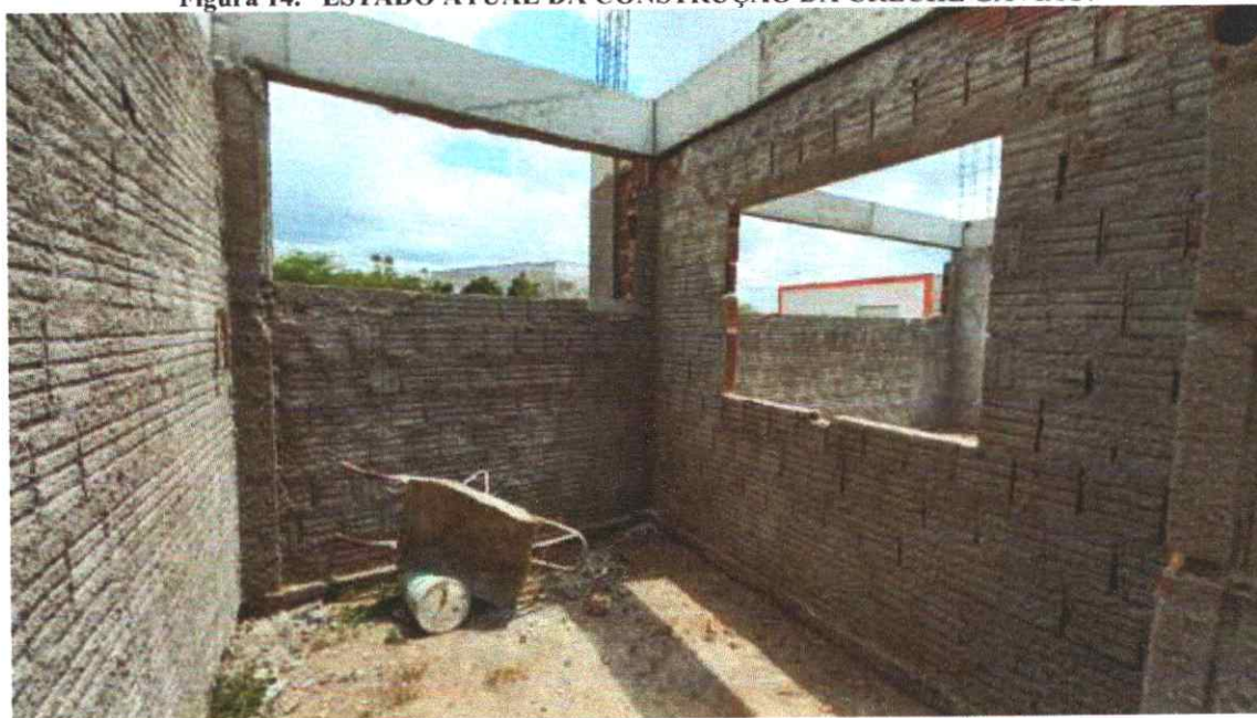
Figura 14. ESTADO ATUAL DA CONSTRUÇÃO DA CRECHE GAVIÃO.
