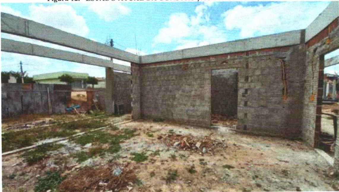
Figura 12. ESTADO ATUAL DA CONSTRUÇÃO DA CRECHE GAVIÃO.
