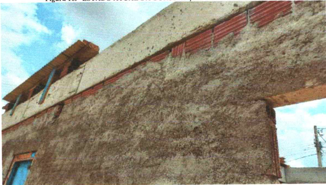
Figura 16. ESTADO ATUAL DA CONSTRUÇÃO DA CRECHE GAVIÃO.
