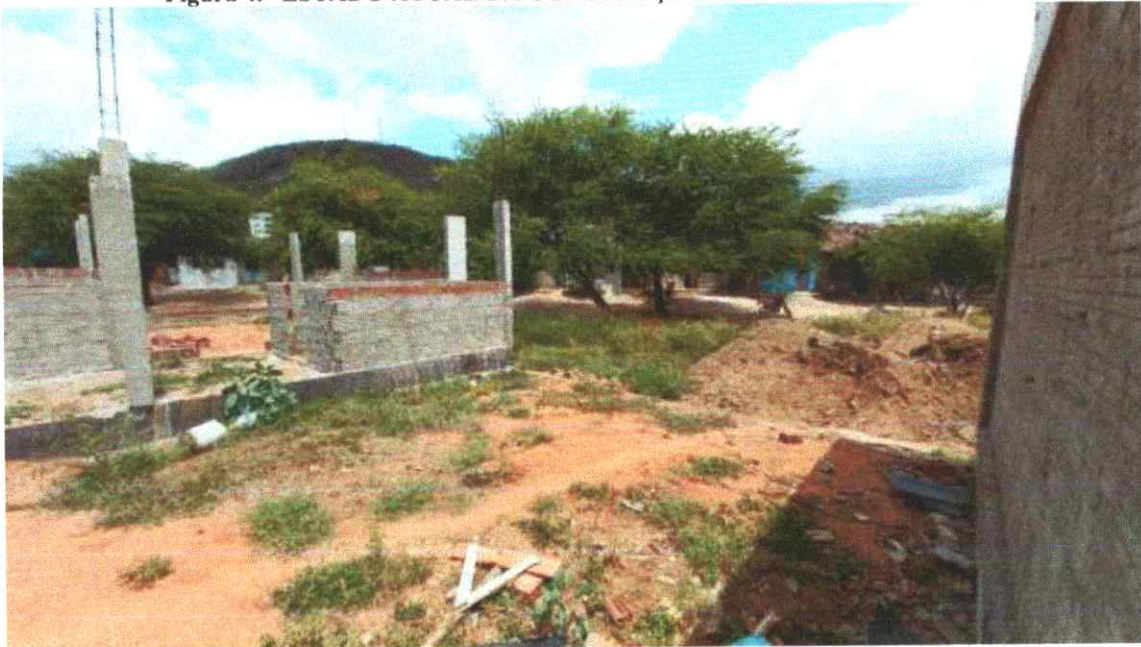
Figura 4. ESTADO ATUAL DA CONSTRUÇÃO DA CRECHE GAVIÃO.
