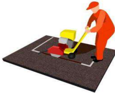
Figura 2 - Corte e remoção do revestimento asfáltico
