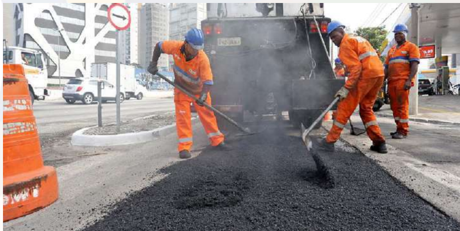
Figura 4 - Espalhamento da Massa Asfáltica
