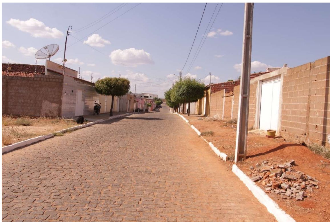
Fotografia 10 –Rua Severo Marques
