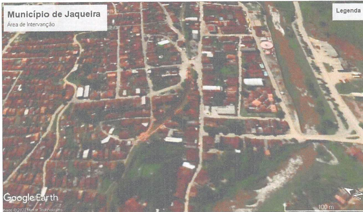
TRECHO DE INTERVENÇÃO
